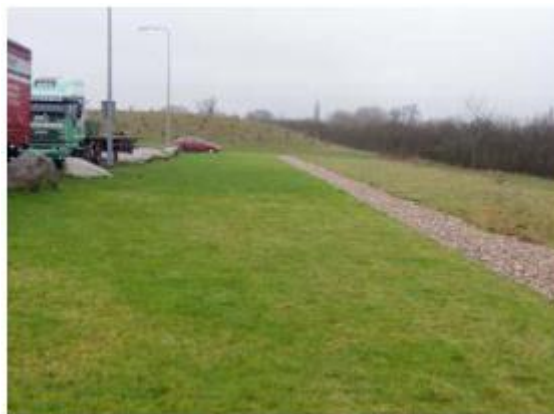
Figura 4. Ejemplo de franjas filtrantes
