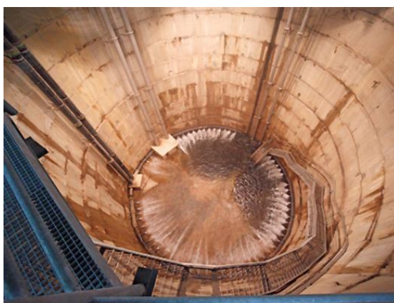
Figura 1. Ejemplo de tanque de tormenta
