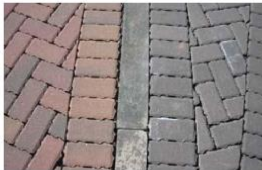
Figura 6. Ejemplo de pavimento permeable
